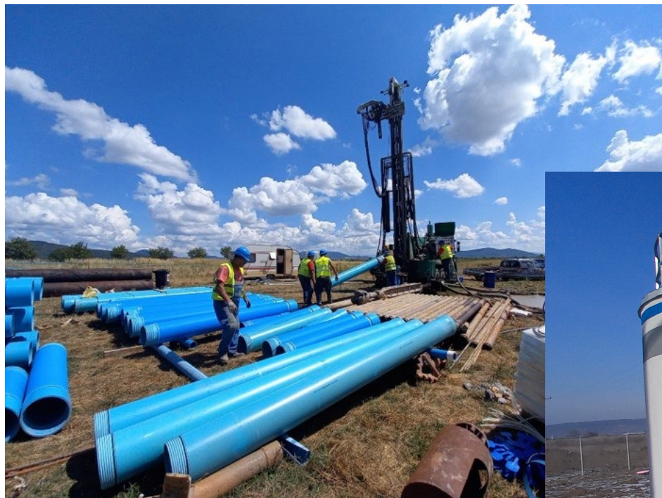
Lucrări de forare la GA1 Băbești
